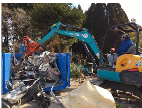
瓦礫の撤去作業
