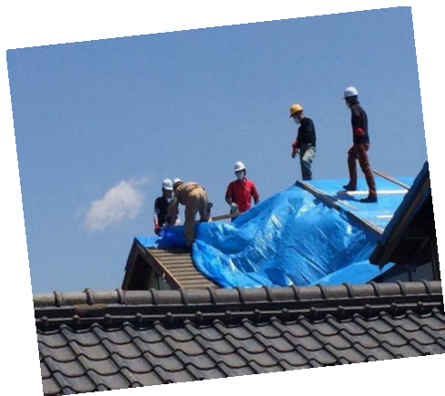
屋根の瓦下ろしとブルーシート養生
