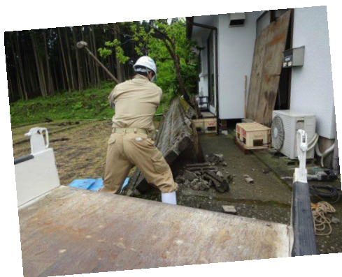
倒れたブロック塀の撤去
