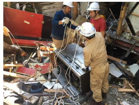
家屋の一部解体
